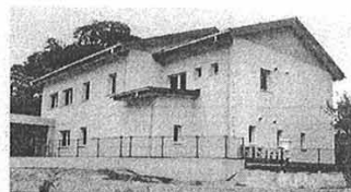
外断熱を採用した介護サービス施設(茅野市)
